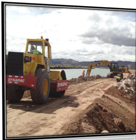
COMPACTACIÓN DE DIQUE EN TRAMO DR-01 RAMIS
