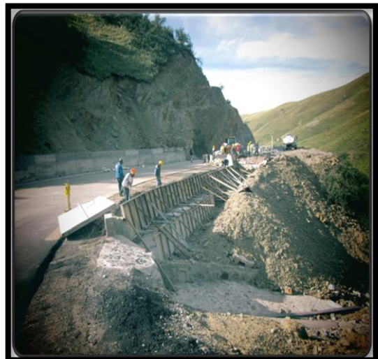
ENCOFRADO PARA MURO DE CONTENCIÓN MARGEN DERECHO EN LA PROG. 11-149 A 11+170
