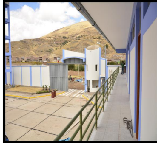
VISTA INTERIOR DEL ALMACEN CENTRAL GRP
