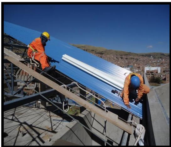
COLOCACION DE CALAMINON EN EL AUDITORIO
