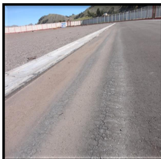
VISTA DE LA PISTA ATLETICA
