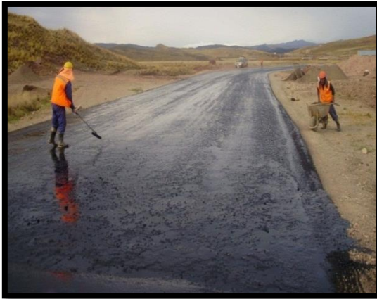
IMPRIMADO CON MC-30 A NIVEL DE LA BASE DE CARPETA ASFALTICA
