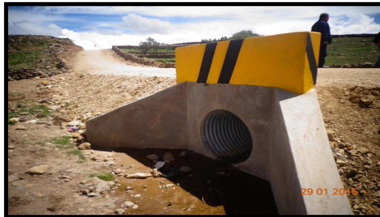
PINTADO DE PARAPETOS EN ALCNTARILLA OBRA MANT. PERIODICO CARRETERA PU-137 PAUCARCOLLA - ATUNCOLLA
