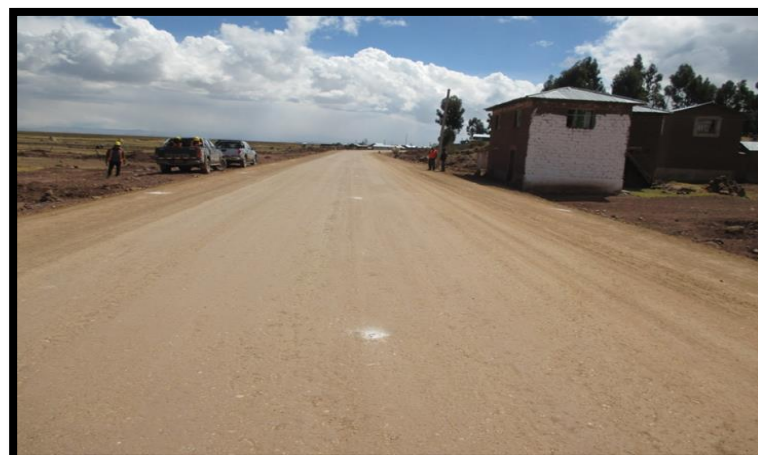
SUB BASE TERMINADA TRAMO I : CAPACHICA - LLACHON
