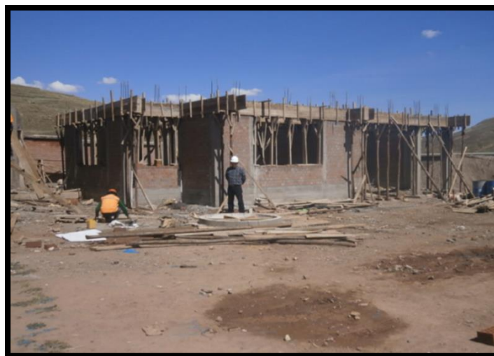
RELLENO Y COMPACTADO EN EXTERIORES LATERALES Y POSTERIORES DEL BLOQUE 2
