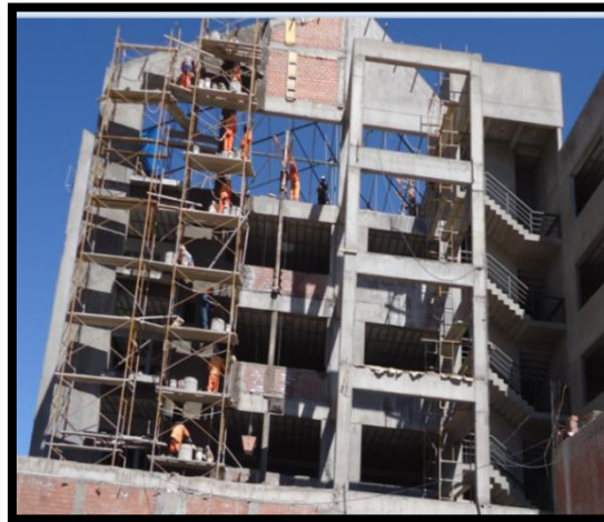
TARRAJEO EN PAÑOS EXTERIORES 5TO NIVEL
