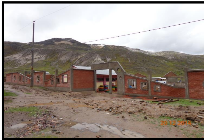
ESTADO REAL DE LA OBRA EN EL COMPONENTE DE CERCO PERIMETRICO EN LA PARTE FRONTAL
