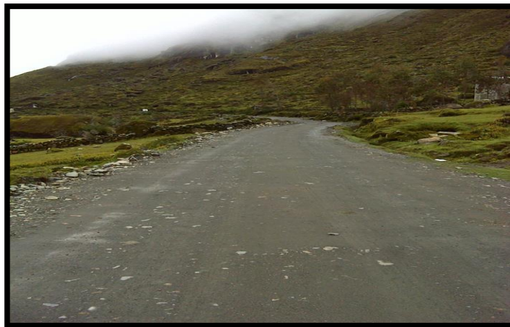
SUPERFICIE DE RODADURA EN BUEN ESTADO LIMBANI - PHARA
