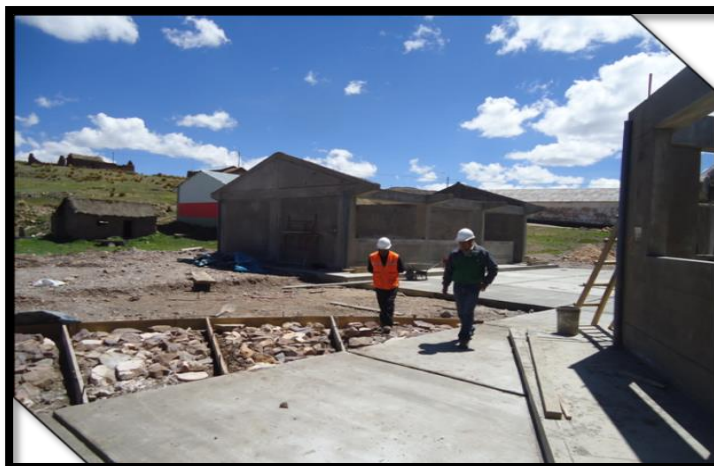
TRABAJOS DE EMPEDRADO, ENCOFRADO Y CONCRETO EN PATIO DE HONOR
