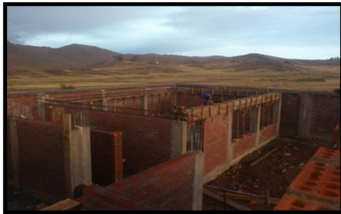
ESTRUCTURA EDUCATIVA CON SEGUNDO PISO MUROS COLUMNAS VIGAS Y FALSO PISO ACABADO
