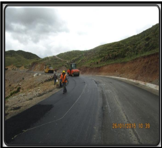
VACEADO COLOCADO DE MEZCLA ASFALTICA EN CALIENTE.
