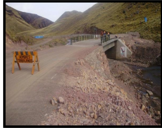
COLOCADO DE LA BARANDAS LATERALES DEL PUENTE PARINA
